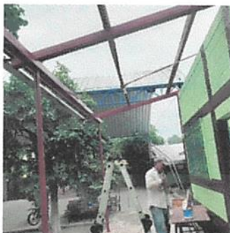
Foto 5: SUSTITUCIÓN DE LAMINAS Y CAPOTES DE AULAS
