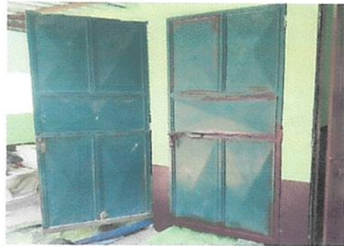
REPARACION Y MANTENIMIENTO DE PUERTAS
