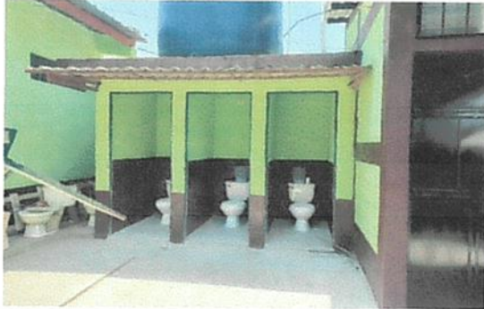
Foto1: REPARACION Y COLOCACION DE BAÑOS
