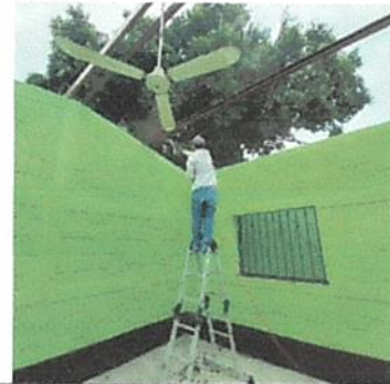
PINTURA DE MUROS DE EXTERIORES E INTERIORES DE AULAS
