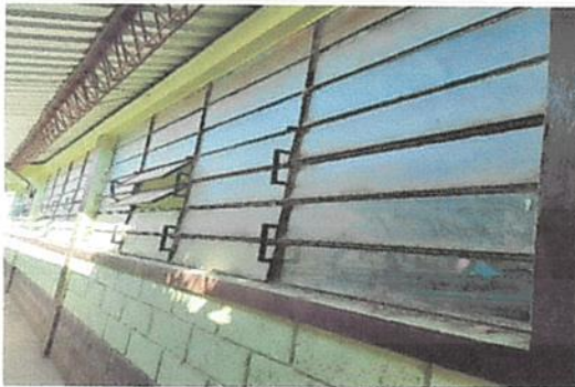
SUSTITUCION Y COLOCACION DE BALCONES DE AULA UNO
